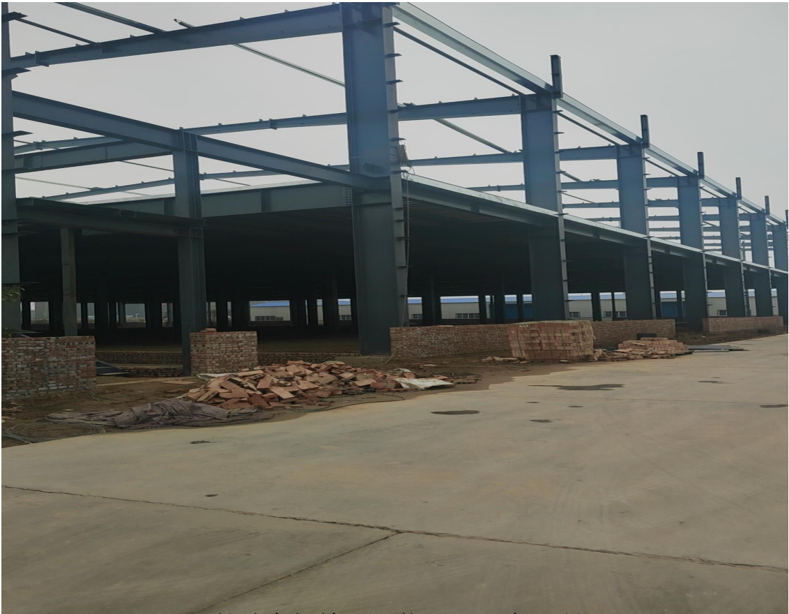
扩建车间施工现状（2024年1月）
