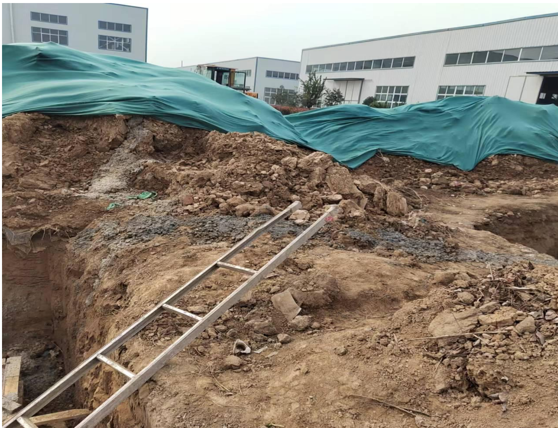
施工过程中的临时苫盖（2023年11月）
