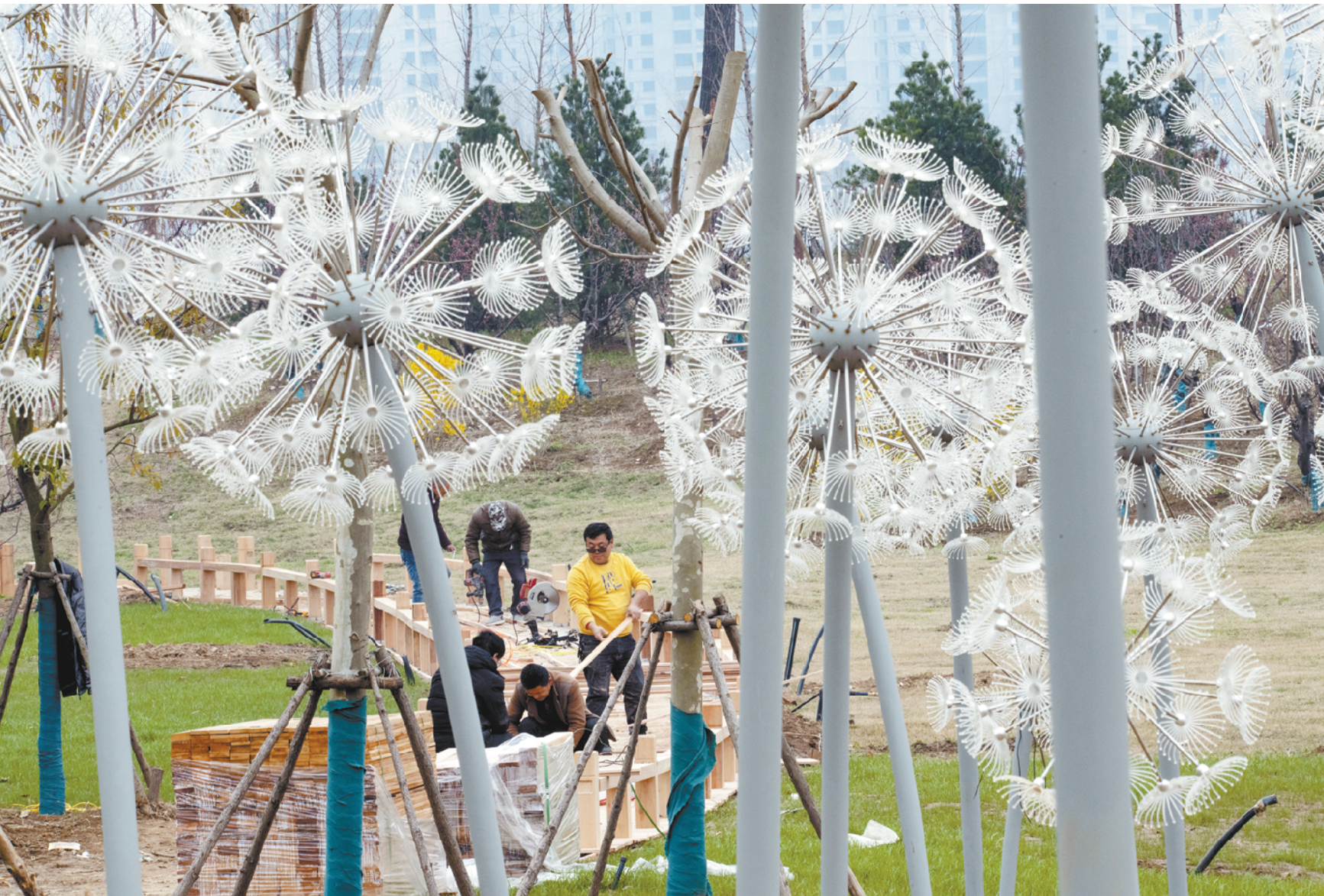
春暖花开,位于周口中心城区的沙颍河景观带建设工地上,工人们正在紧张施工。3月21日上午,记者在中原路大桥东侧的沙颍河北岸看到,工人们正在休闲观光走廊上安装木质栏杆。
