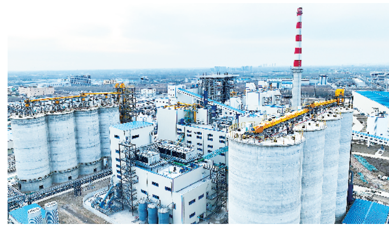
临港开发区重点项目建设现场。记者 宋风 摄
