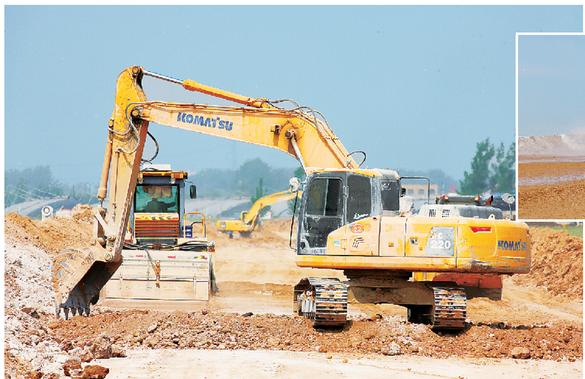
道路是城市发展的“中枢神经”,一头连着发展,一头连着民生。5月8日,周口中心城区建设大道东延工程正在紧张施工中。上图:洒水车正在进行喷淋降尘作业。左图:挖掘机正在整理路基。
