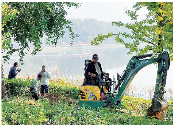
市园林绿化中心工作人员正在挖沟排水。
